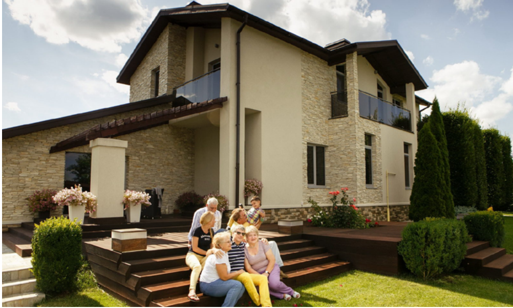
● Комбинированный фасад: декоративная штукатурка и натуральный камень
